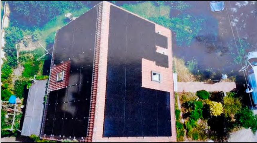
PV-Splitanlage mit 24,5 kW Generatormennleistung: Von außen ist nicht zu erkennen, wo die Anlagengrenze verläuft. An beiden Wechselrichtern ist jeweils ein String auf der Ost- und der Westseite
