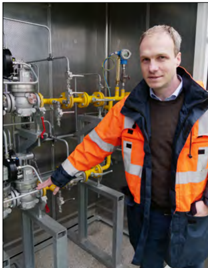
Bild 2: Manuel Gaßner von Energienetze Bayern erklärt die Gasdruckregel- und Messanlage
