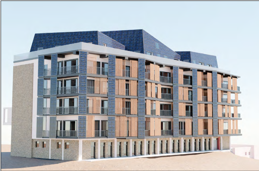
Bild 1: Entwurf für das Bettenhaus: Montage der Solarkollektoren an den Fassaden und an den Penthouse-Apartments, die auf dem Flachdach entstehen
