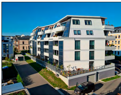
Bild 2: Bei dieser Wohnanlage sind die Solarkollektoren auf der Rückseite und an einer Seite des Gebäudes angebracht
