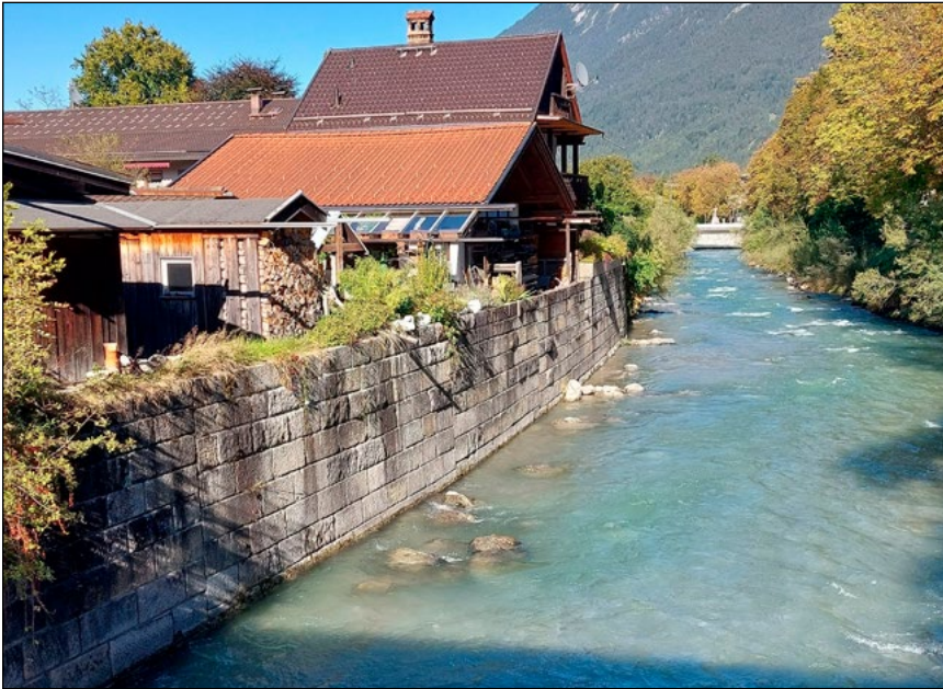
Bild 1: Die Loisach in Garmisch-Partenkirchen hat schon kurz nach dem Wasserkraftwerk wieder viel ungenutzte Strömungsenergie
