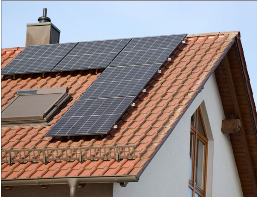
Bild 1: Netzanfragen für Photovoltaik müssen zukünftig nicht nur für Hausanlagen, sondern auch für Anlagen bis 30 kWp schnell beantwortet werden
