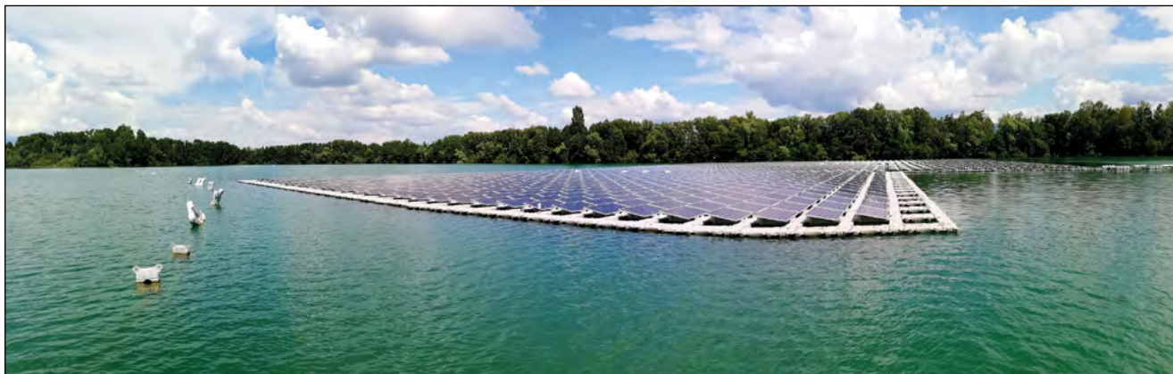
Bild 2: Floating-PV-Anlage auf einem Baggersee bei Renchen/ Baden mit einer Leistung von 750 kWp
