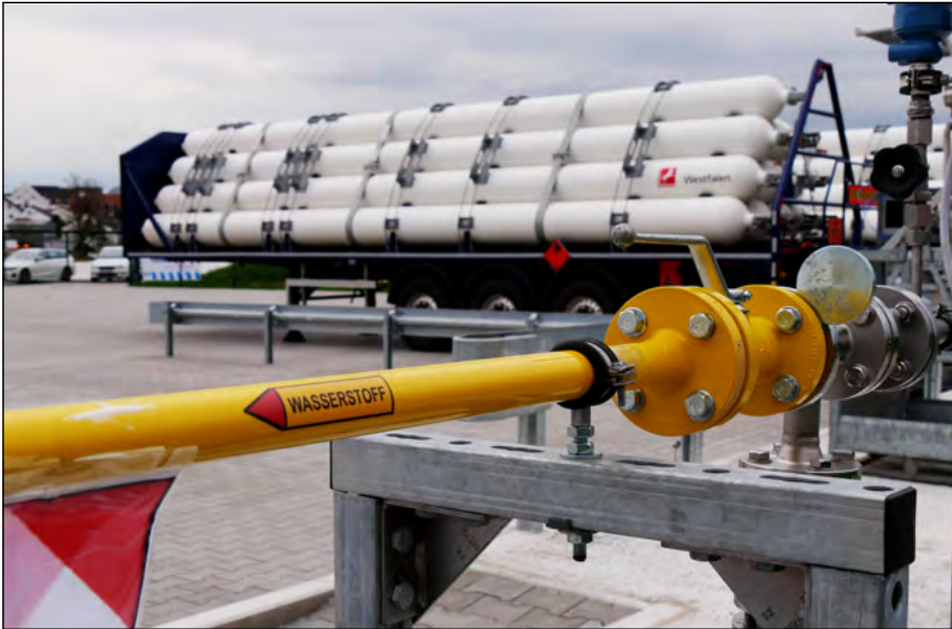
Bild 1: Wasserstoff-Leitung und Transporttrailer im Hintergrund
