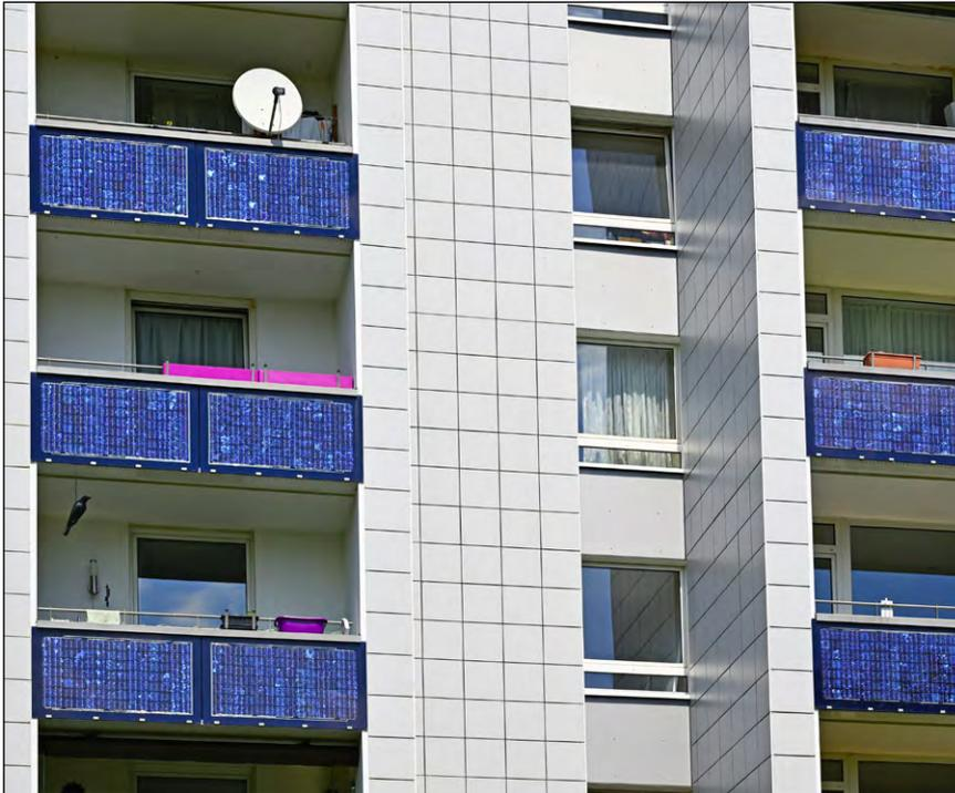
Bild 1: Steckersolar-Geräte
