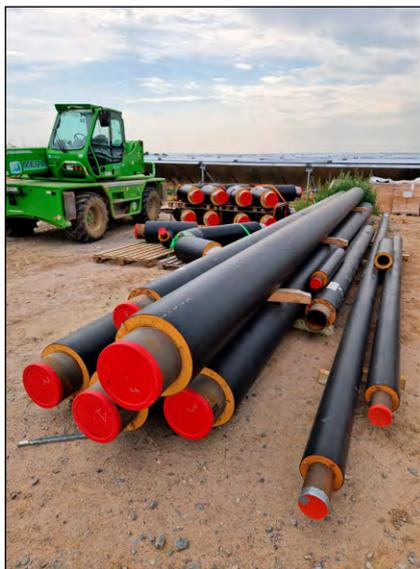
Bild 4: Die Verrohrung im Solarfeld erfolgt unterirdisch. Die doppelwandigen Rohre haben Nennweite von bis zu DN250
