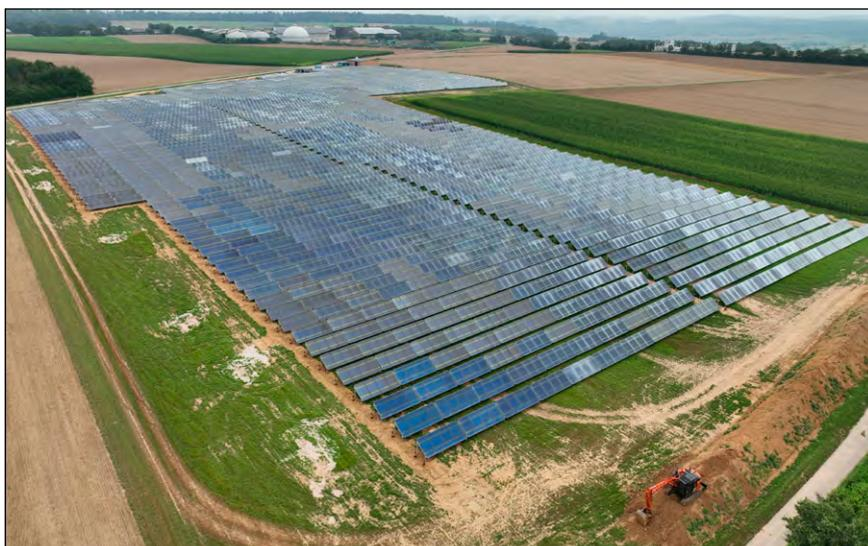
Bild 5: Aufräumen nach der Bauphase. Der Bagger modelliert das Aushubmaterial der Rohrleitungen für den Artenschutz
