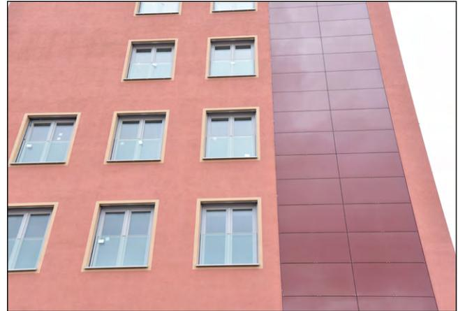
Bild 2: Am Alten Verwaltungsgebäude wurde eine Fassaden-Photovoltaikanlage angebracht, die sich optisch an die rotfarbenen Wände des Gebäudeensembles anpasst.
