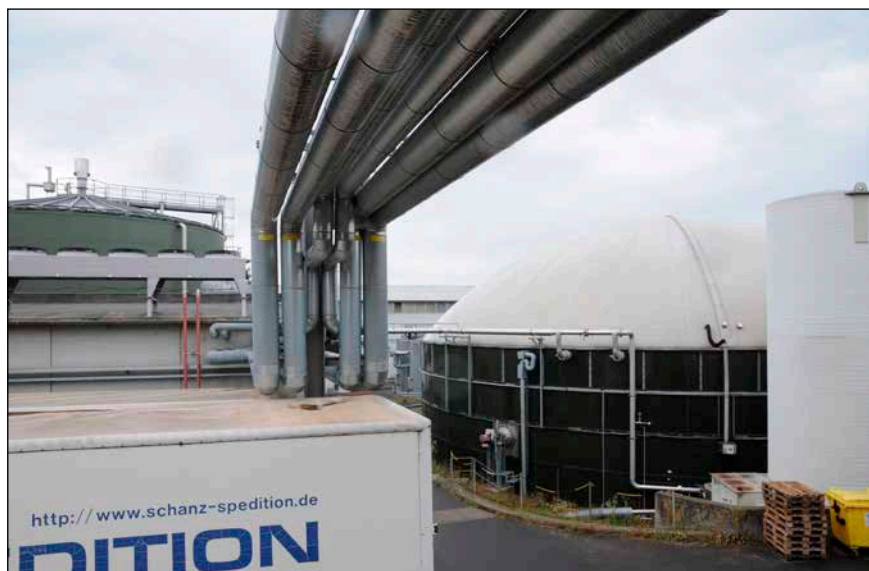
Bild 2: Die Biogasanlage auf dem Firmengelände in Brensbach umfasst unter anderem einen hohen Fermenter (links hinten), das Blockheizkraftwerk (zwischen dem Fermenter und den Containern) sowie einen Kombispeicher mit Gasspeicher (rechts).
