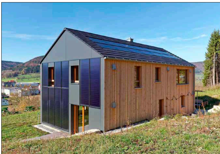
Bild 2: Nachhaltiges Baukonzept: Holzständerbauweise mit Strohballen als Wärmedämmung sowie Solarthermie und Photovoltaik. Ausgezeichnet mit dem ersten Platz im Holzbau-Plus-Wettbewerb des Bundesministeriums für Ernährung und Landwirtschaft.
