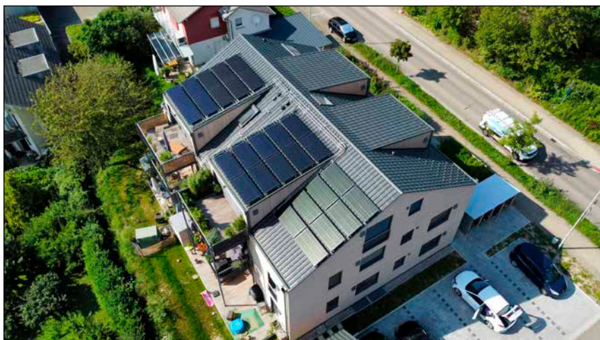
Bild 2: 28 PVT-Kollektoren auf dem Dach dieses Sechs-Familien-Hauses in Heitersheim liefern Strom und Wärme, die von einer Wärmepumpe genutzt werden.
