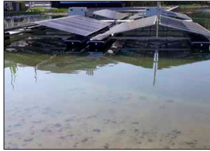
Bild 5: Floating-PV kühlt das Wasser und wird selbst durch das Wasser gekühlt
