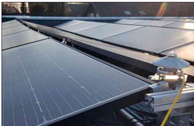
Bild 2: Auf den ersten Blick kaum von PV-Modulen zu unterscheiden – aber hinter den Zellen fließt ein Wärmeträger, der die Wärme nutzbar macht und zugleich die Zellen kühlen kann
