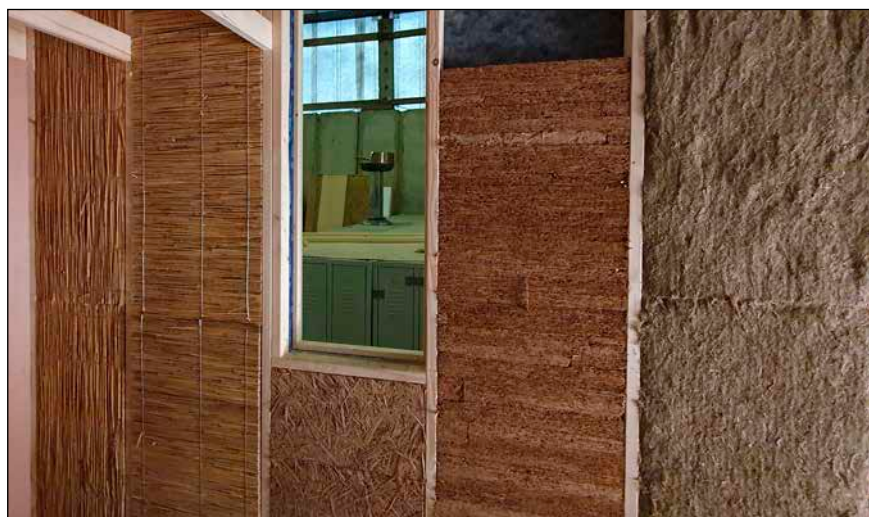
Bild 6: Dämmung aus Schilfplatten, Rohrkolbenplatten und Grasfasermatten
