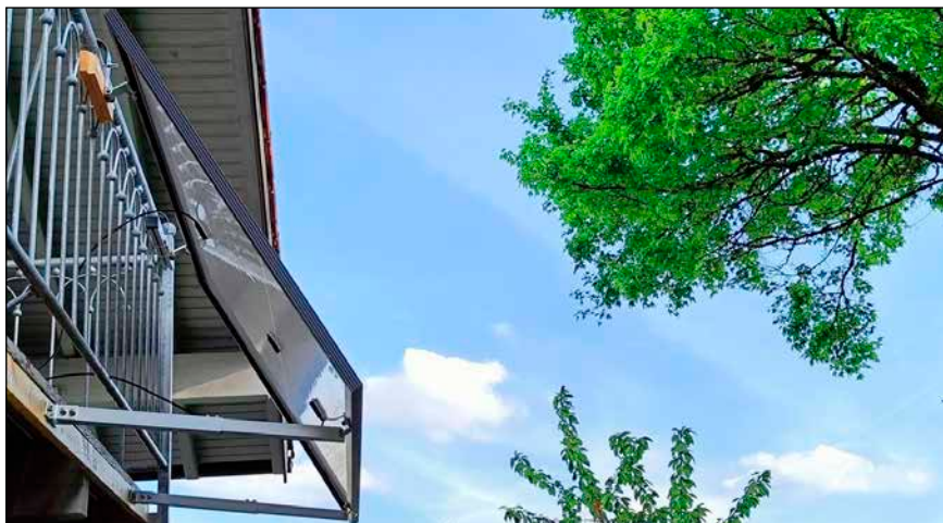
Bild 3: Dieses Panel wurde mit Aufständerung befestigt, um einen besseren Winkel zu erreichen.
