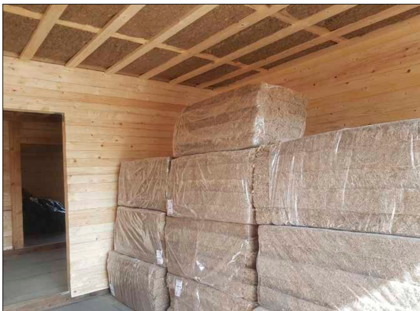
Bild 4: Grasfasermatten von Gramitherm zur Innendämmung eines Kindergarten-Neubaus
