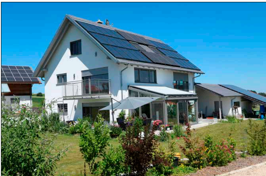
Bild 1: Merkmal klassischer Sonnenhäuser sind großflächige Kollektorfelder und leistungsfähige Speicher.
