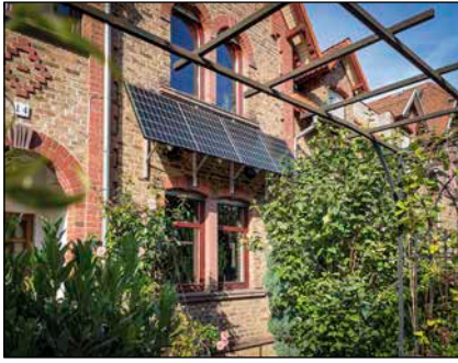
Bild 2: Wandmontage eines Steckersolargeräts mit dem System Tric F Fassade von Wagner Solar
