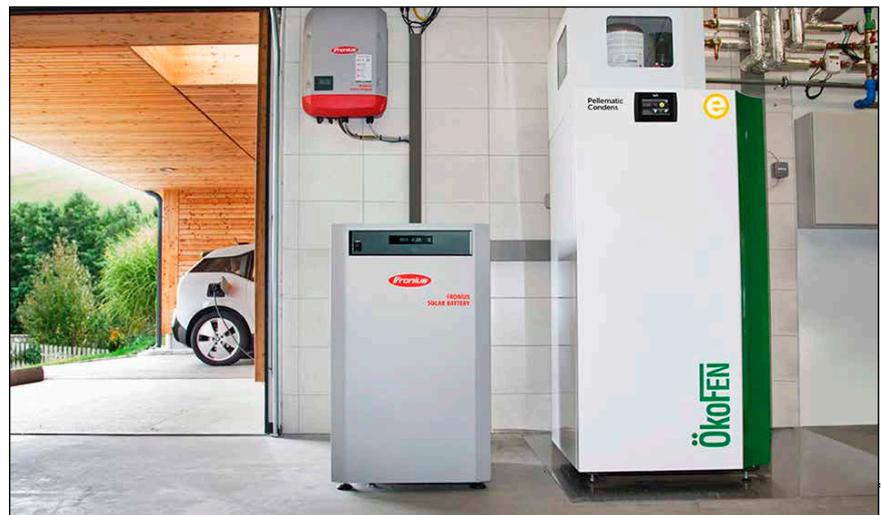
Bild 2: Das „myEnergy365“-System zur unabhängigen und ökologischen Strom- und Wärmeerzeugung im Eigenheim besteht aus einer Strom produzierenden Pelletsheizung, einer Batterie, einem Wechselrichter und einer Photovoltaikanlage.
