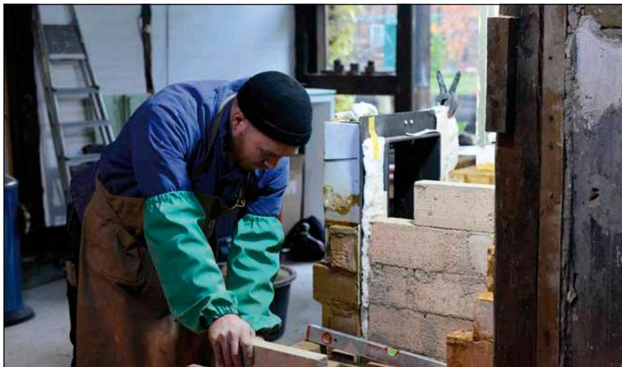
Bild 2: Ofenbauer Vadim Berezin bei sensiblen Maurerarbeiten am Grundofen
