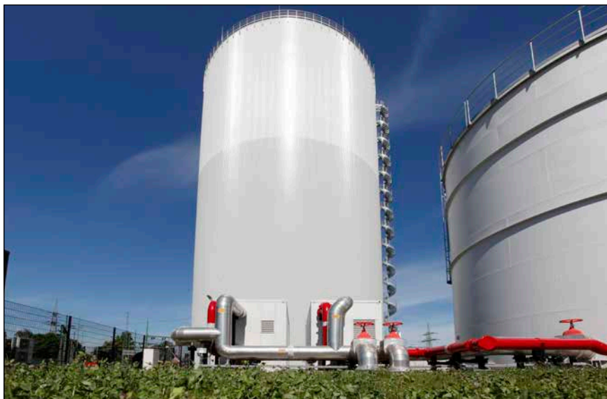
Bild 2: Mit dem Wärmespeicher können die Stadtwerke Düsseldorf die Strom- und Wärme-erzeugung ihres Erdgaskraftwerks vom Fernwärmebedarf der Stadt entkoppeln.
