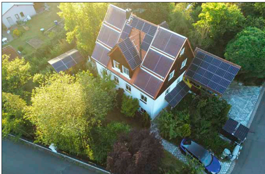
Bild 7: Drohnenaufnahme: Die 21 verschiedenen Ausrichtungen der 30 kWp Anlage und 40 m 2 Vakuumröhren
