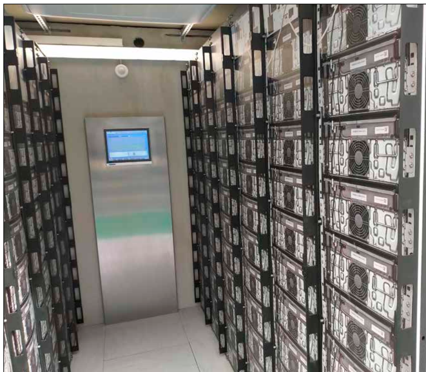
Bild 2: Große Stromspeicher (hier ein Blick in einen Speichercontainer mit vielen einzelnen Batterieeinheiten) können auch Stabilität für das Stromsystem bieten.
