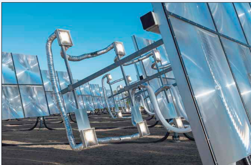
Bild 1: Solarfeld mit Fresnellinsen-Kollektoren
