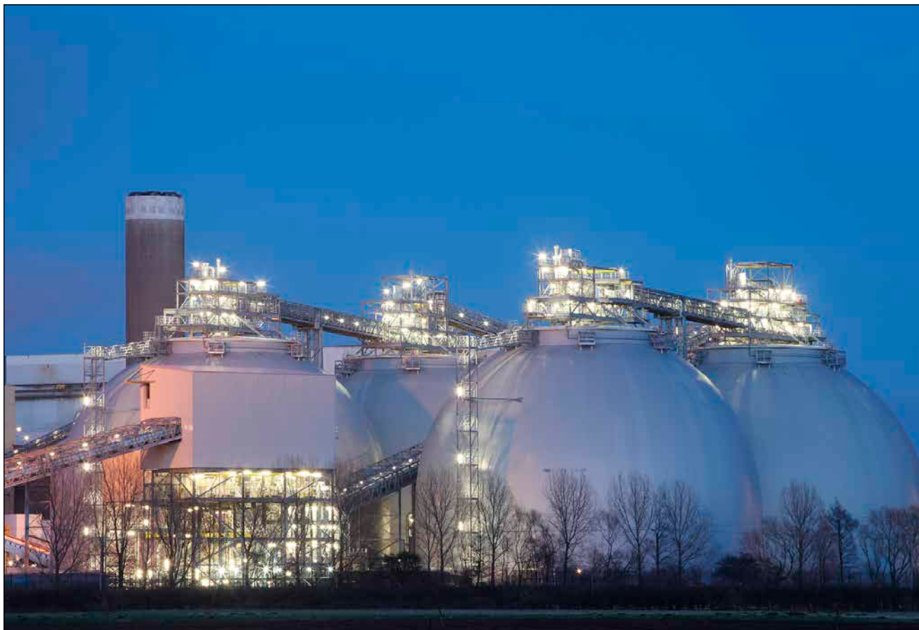
Bild 1: Pelletslager am Drax-Biomassekraftwerk in North Yorkshire / England
