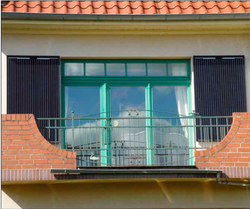
Bild 1: Zwei Steckersolargeräte als Wandmontage auf dem Balkon
