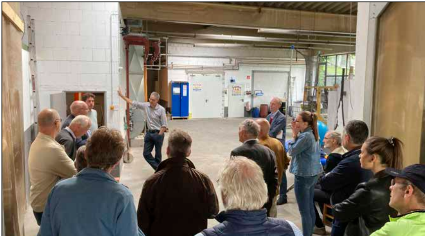
Bild 1: In der Nahwärmezentrale Altenmellrich
