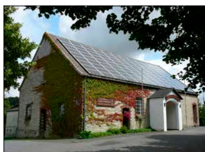
Bild 2: Die Schützenhalle in Altenmellrich – natürlich mit PV-Anlage
