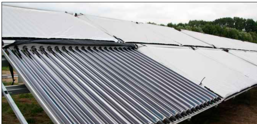
Bild 2: Bis zur Inbetriebnahme sind die Vakuumröhrenkollektoren in Greifswald noch abgedeckt.
