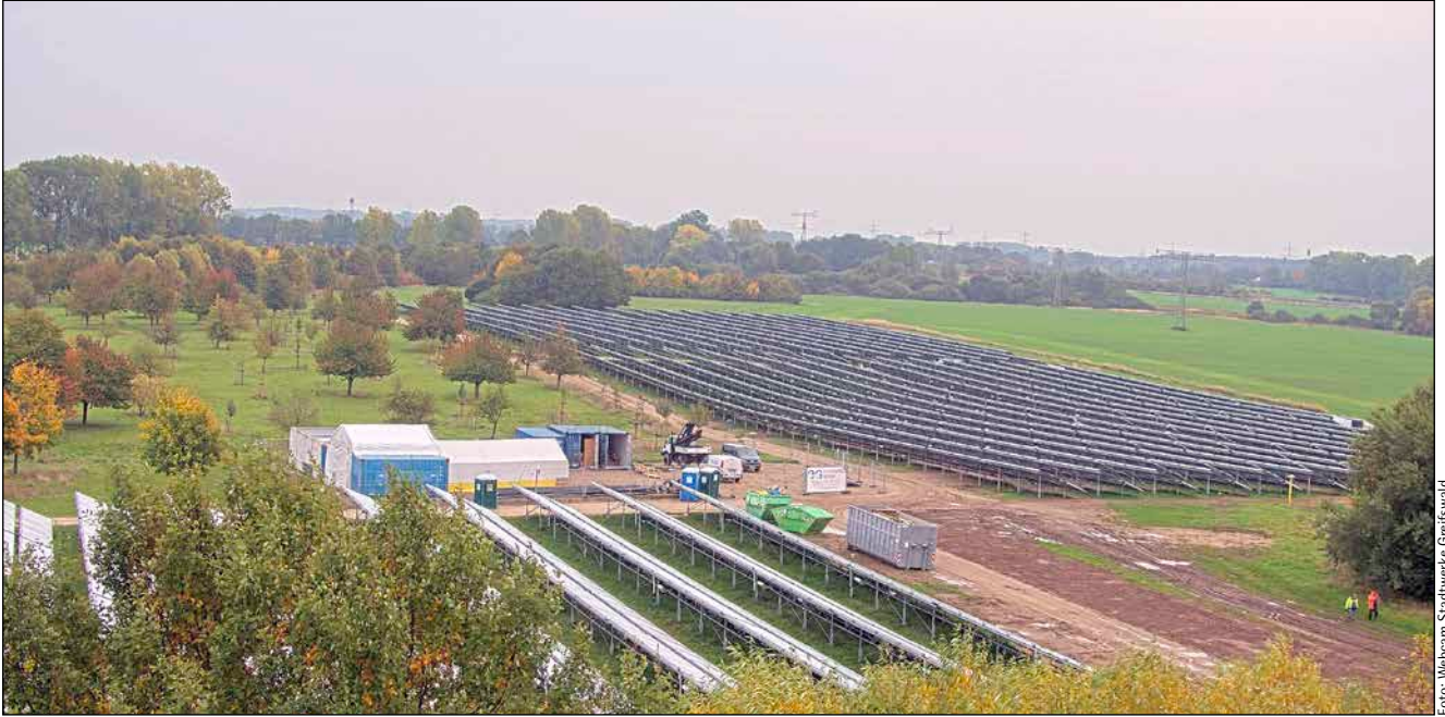
Bild 1: Ende Oktober 2021 sind die Vakuumröhrenkollektoren in Greifswald bereits installiert. Hinter dem Kollektor sind die Ausgleichsmaßnahmen zu sehen. Es handelt sich um eine Obstbaumwiese und Eidechsenquartiere.
