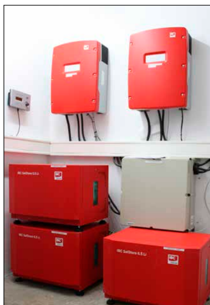
Bild 3: Dreiteilige Speichereinheit mit 19,5 kWh Bruttokapazität auf einem Schweinemastbetrieb; oben die Wechselrichter, unten die drei Lithium-Ionen-Batteriespeicher und die Back-up-Box für die Notstromversorgung
