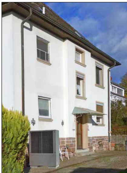
Bild 1: Erst dämmen, dann Wärme pumpen: Altbau mit außenstehender Wärmepumpeneinheit einer Luft-Wasser-Wärmepumpe
