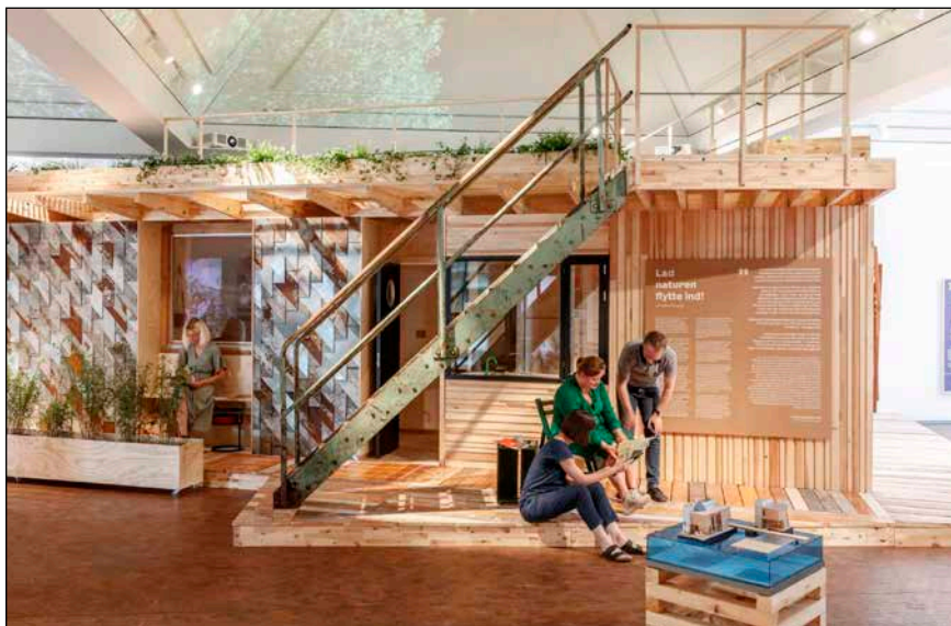
Bild 1: Einsatz von bereits einmal benutzten Baustoffen
