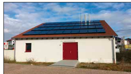
Bild 3: Im Neubaugebiet Osterfeld wird Solarthermie und Kraft-Wärme-Kopplung zur Wärmeversorgung eingesetzt.
