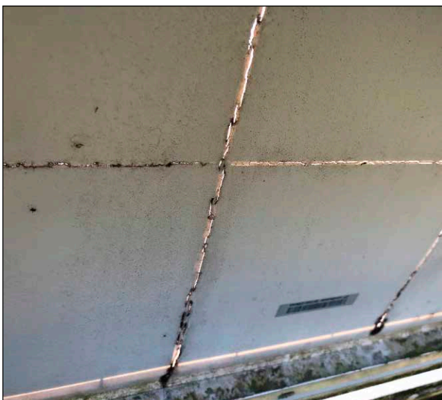
Bild 1: Risse in der Rückseitenfolie von Solarmodulen
