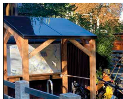
Bild 2: Technische Daten der solaren E-Bike Station: Solarmodule 2 x 305 W, Wechselrichter 600 VA; 4 Steckdosen, Holzgestell Lärche massiv (aus der Söhre/Hessen).
