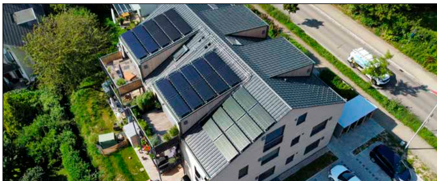
Bild 1: Kernsaniertes Mehrfamilienhaus beheizt mit Wärmepumpe und PVT-Wärmepumpenkollektoren
