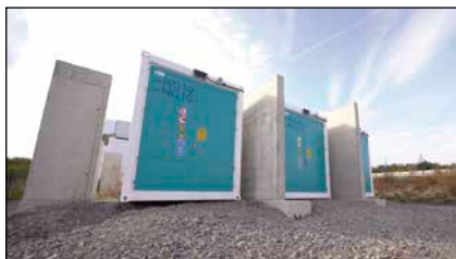
Bild 2: Der 8-MW-Batteriegroßspeicher mit einer Kapazität von 13,6 MWh ist das jüngste Projekt des Stadtwerks.
