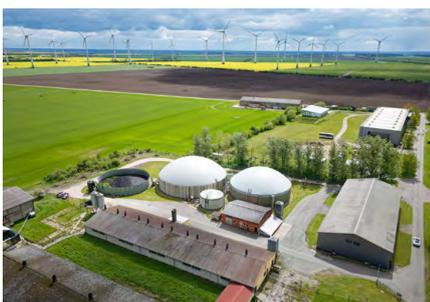
**Biogasanlage** Bei den beiden großen weißen Behältnissen handelt es sich um die Fermenter, in denen Gülle und Mais zersetzt werden
