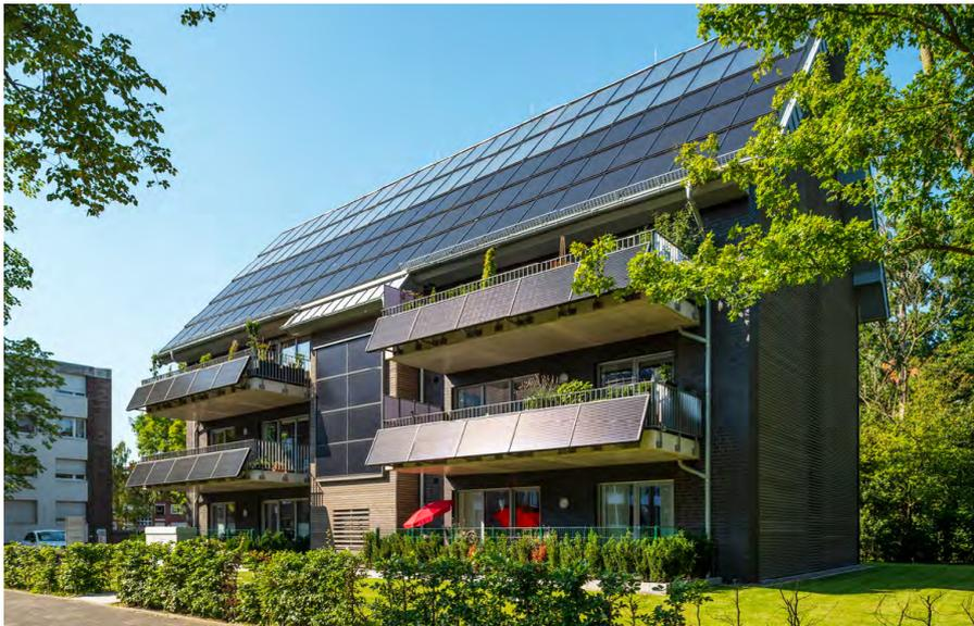
**Flatrate** Der hohe Solarertrag der Photovoltaik- und Solarthermie-Anlagen auf dem Dach, an der Fassade und an den Balkonverkleidungen ermöglicht die Pauschalmiete mit Energieflatrate.
