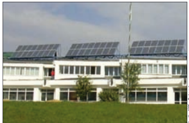
Bild 5: Die 10 kWp netzgekoppelte PV-Anlage auf dem Dach der Transilvania-Universität in Brasov (Kronstadt), Baujahr 2007
