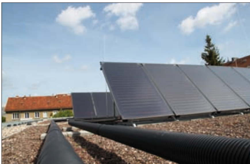
Bild 1: Aufgeständerte Kollektoren auf dem Flachdach der Hermann-Hesse-Strasse 3 a-c im Berliner Stadtteil Pankow
