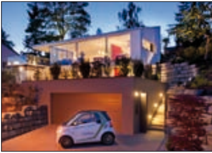
Bild 1: Architektur und Technik in Harmonie oder Gebäude als Solarkraftwerk
