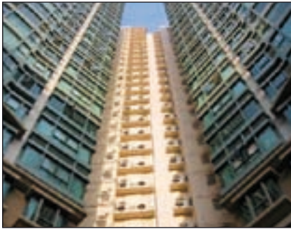
Bild 1: Klimageräte in Hongkong
