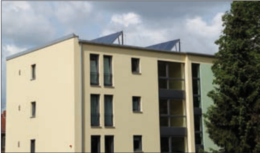
Bild 2: Die EWG Pankow hat sich in der Hermann-Hesse-Straße für eine bivalente Lösung Solar und Wärmepumpe entschieden
