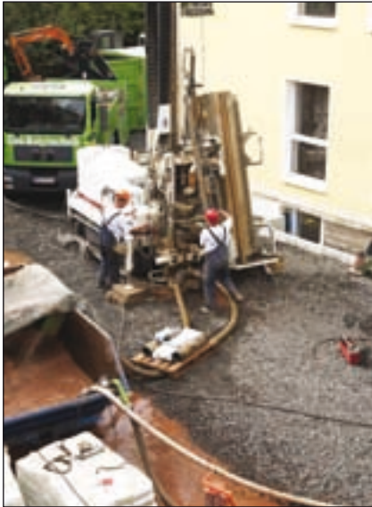
Bild 4: Um hohe Leistungen wie im Mehr-geschosswohnungsbau zu erzielen, braucht man erdgekoppelte Wärmepumpen mit Tiefensonden
