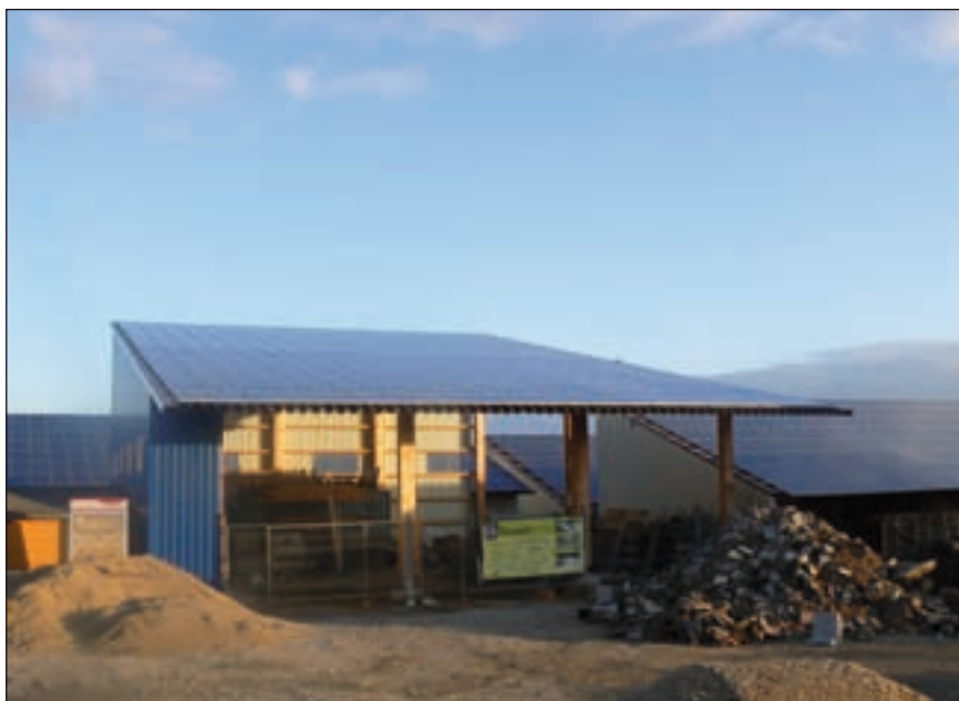
Bild 1: Mit Photovoltaik überdachte Lagerplätze
