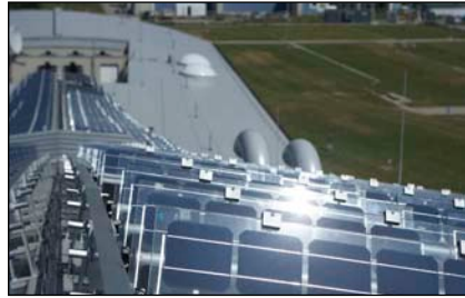
Bild 7: Ein besonders ausgeklügeltes Projekt ist die einachsig nachgeführte PV-Lamellen-Anlagen auf der neuen Hauptleitzentrale der Verbund-Austrian Power Grid AG in Wien-Südost. Ertex Solar produzierte hierfür die Paneele.
