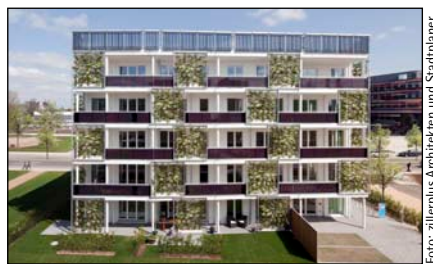
Bild 3: Das Wohnhaus „Smart ist grün“ ist Rahmen der Internationalen Bauausstellung (IBA) in Hamburg-Wilhelmsburg entstanden. Es besitzt eine fassadenintegrierte Photovoltaik, Röhrenkollektoren auf Dach und Attika sowie Phasenwechselmaterialien als Speichertechnologie
