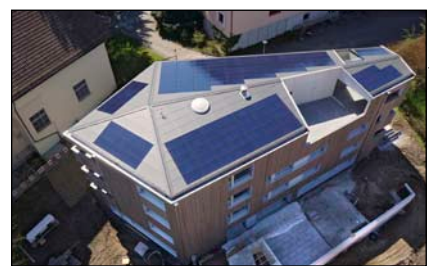
Bild 2: Durch einen ungewöhnlichen fünfeckigen Grundriss wurde es beim Wohn- und Geschäftshaus im schweizerischen Kriens erforderlich, die Solarflächen auf sechs Teilflächen des Daches zu integrieren. Das Projekt im Kanton Luzern hat eine installierte Leistung von 30,59 kWp.
