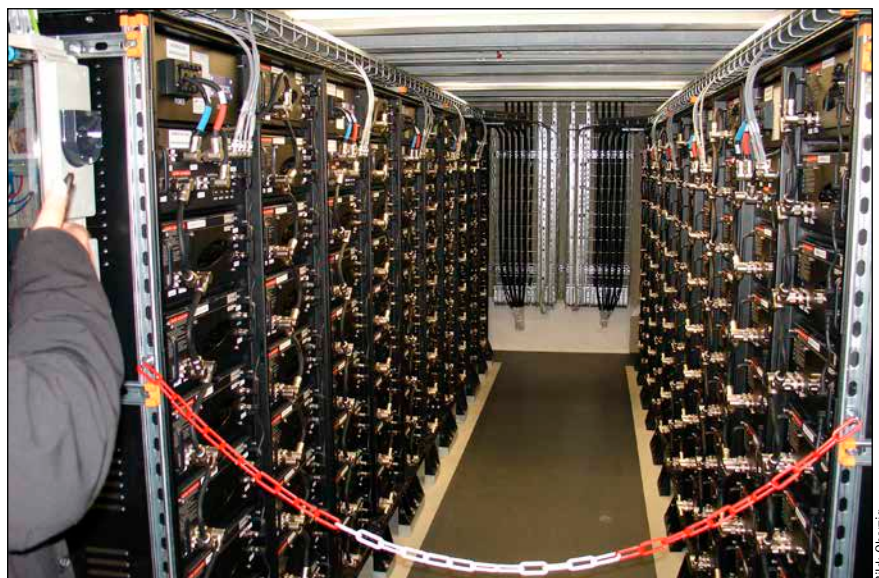
Bild 4: Blick in den 5 MW Speicher der WEMAG in Schwerin, der die Netzstabilität in Teilen Mecklenburg-Vorpommern sichert. In den Racks befinden sich Lithium-Ionen-Elemente.
