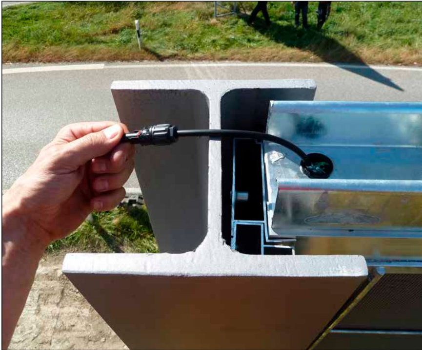
Bild 1: Der integrierte Kabelkanal als Abschluss der Lärmschutzwand wurde nach Fertigstellung der Schallschutzwand verschlossen
