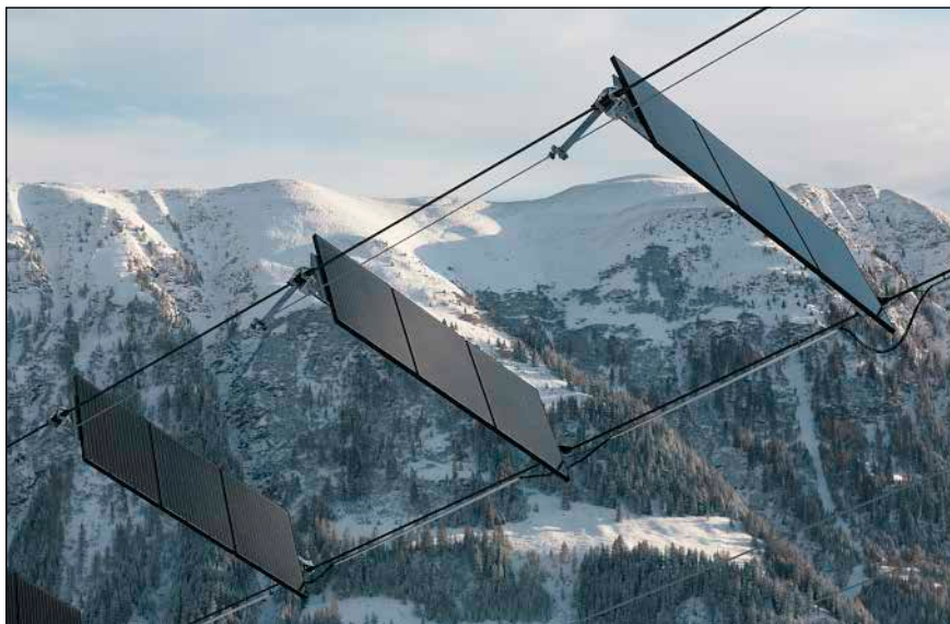
Bild 2: 2016 produzierte der Solarskilift 103.600 kWh. 2017 war sehr sonnig, die nächste Zahl soll noch höher ausfallen.
