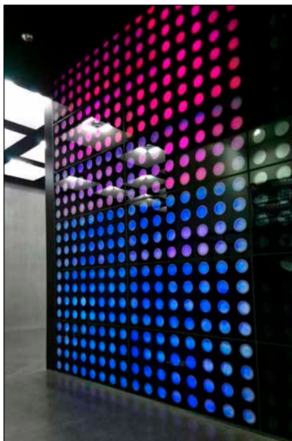
Bild 1: Effizienter Speicher für Sonnenwärme: Im erst teilweise eröffneten Zukunftsmuseum Futurium in Berlin kommt ein Paraffin-Latentwärmespeicher zum Einsatz. Je nach Ladephase wechselt die Farbe.
