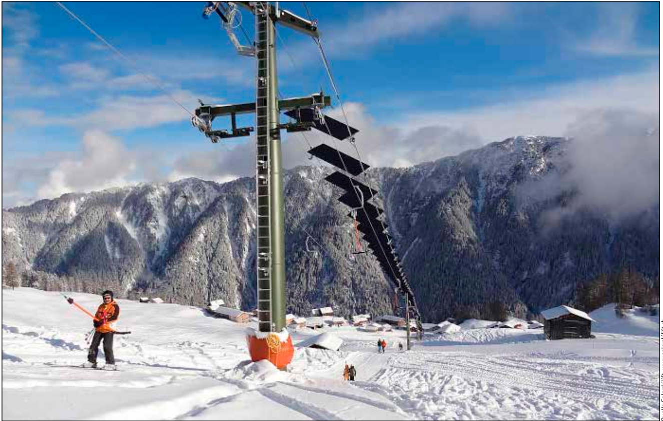
Bild 1: Solarskilift in Tenna
