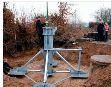
Bild 2: Der Fuß der Kleinwindanlage steht 1,60 m tief im Boden. Das angefüllte Erdreich wird verfestigt.
