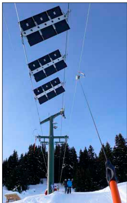
Bild 3: Die sogenannten Solar-Wings wurden in acht Metern Höhe über der Schleppspur montiert.
