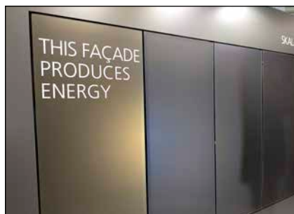
Bild 2: Photovoltaik-Fassadenelemente
