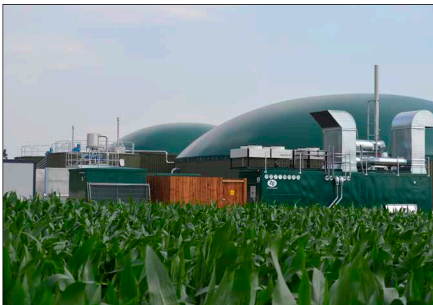
Bild 3: Biogasanlage für die flexible Biogasproduktion
