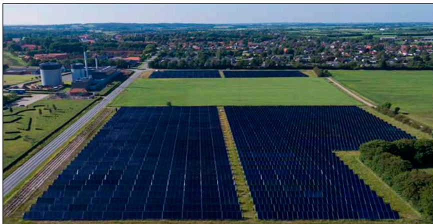
15.300 m 2 (10,7 MW th ) Solarthermie Anlage Løgumkloster
