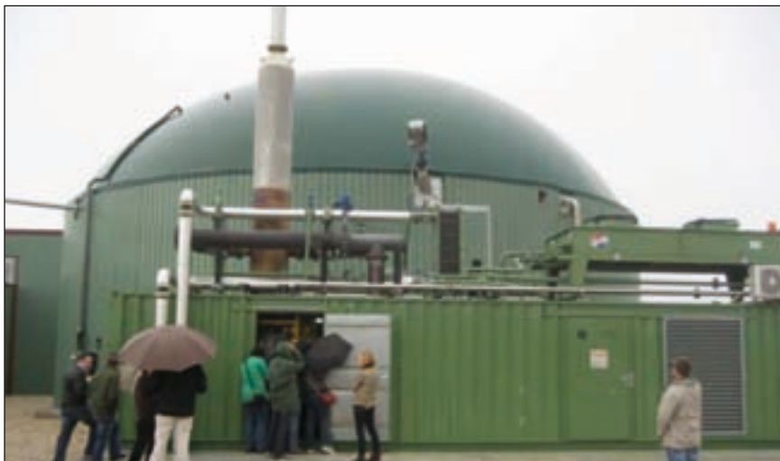
Bild 2: Gärbehälter in San Ramón, Valencia
