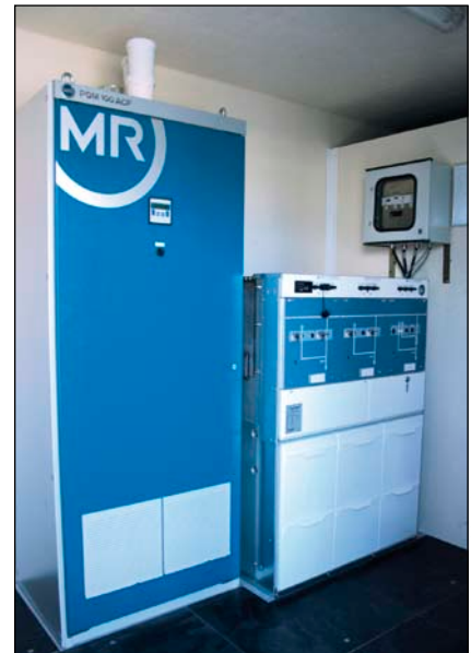
Bild 2: Steuereinrichtungen eines Regelbaren Ortsnetztrafos
