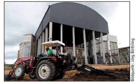
Bild 3: Villa Sara: Galofer S.A. Biomassekraftwerk
