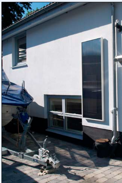
Bild 3: Wandmontage des SolarVenti
