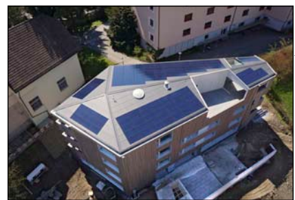
Bild 2: Durch einen ungewöhnlichen fünfeckigen Grundriss wurde es beim Wohn- und Geschäftshaus im schweizerischen Kriens erforderlich, die Solarflächen auf sechs Teilflächen des Daches zu integrieren. Das Projekt im Kanton Luzern hat eine installierte Leistung von 30,59 kWp
