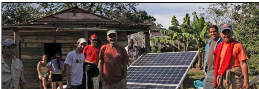
Die Installation wird durch kubanische Fachleute vorgenommen
