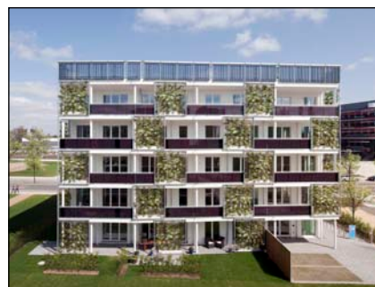
Bild 3: Das Wohnhaus „Smart ist grün“ ist Rahmen der Internationalen Bauausstellung (IBA) in Hamburg-Wilhelmsburg entstanden. Es besitzt eine fassadenintegrierte Photovoltaik, Röhrenkollektoren auf Dach und Attika sowie Phasenwechselmaterialien als Speichertechnologie
