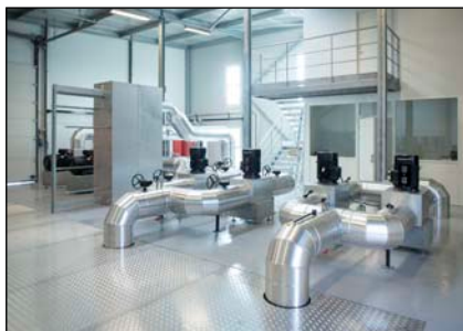
Bild 2: Die Anlage in Grenaa wurde von Arcon inklusive der gesamten Anlagentechnik und Regelung geliefert. Frequenzumformer-geregelte Doppelpumpen erhöhen die Ausfallsicherheit und steigern den Ertrag.
