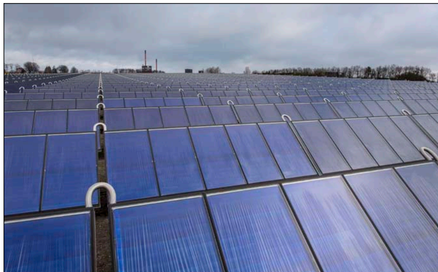
Bild 1: Das 12.000 m 2 Solarwärmesystem für das Fernwärmenetz im dänischen Grenaa. Eine typische Anlagengröße in Dänemark, die als Beispiel für Deutschland gelten kann.
