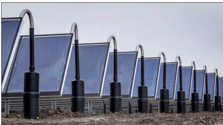
Bild 3: Gut zu sehen ist die industrielle Anschluss-technik mit vorisolierten, doppelten Edelstahlrohren und der Abdeckung für die Absperr- und Regelventile.
