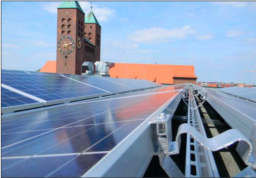
Beispiel für PV-Miete: Das Nürnberger Südstadtbad
