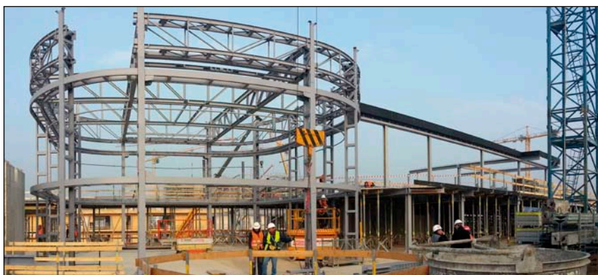
Bild 4: Deutscher Pavillon in der Bauphase Herbst 2014
