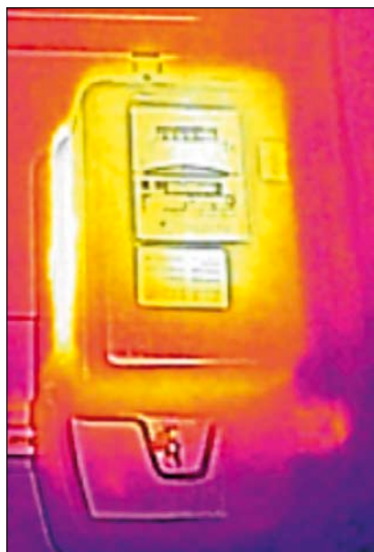
Bild 4: Stromzähler entwickelt Wärme
