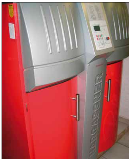
Bild 4: Holzpelletkessel zur Wärmeversorgung
