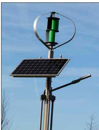
Bild 7: Innovative Photovoltaik-Windkraft-Kombinalage zur Versorgung der LED-Parkplatzleuchten
