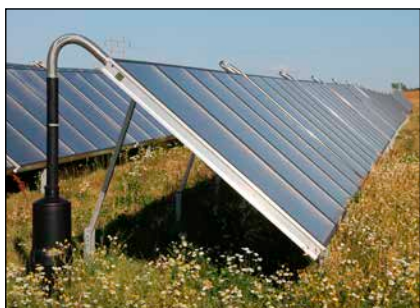
Bild 2: Flachkollektoranlage in Freilandaufstellung
