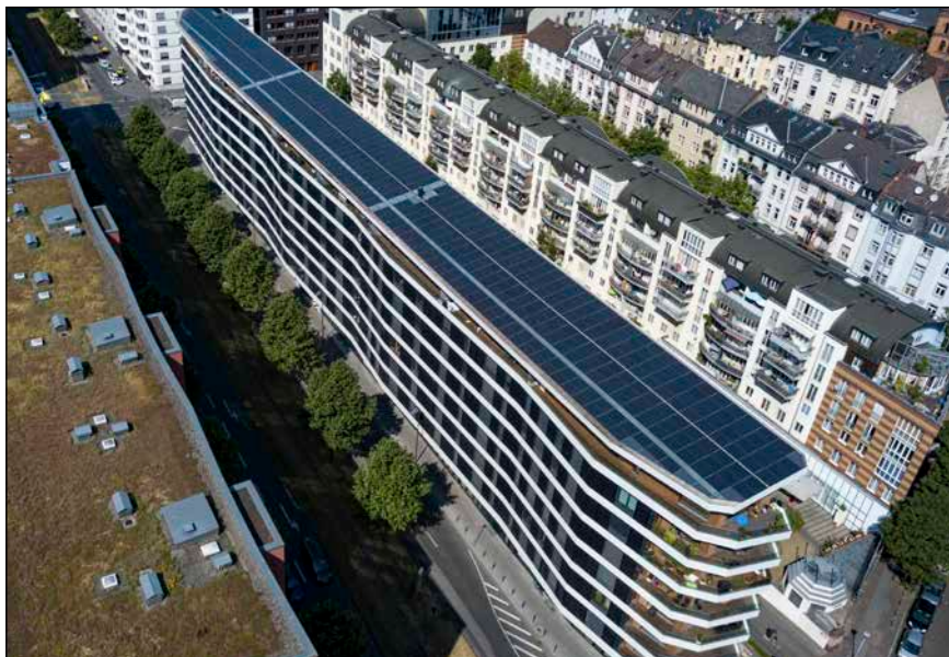
Dachaufsicht des „Aktiv-Stadthauses“ der ABG in Frankfurt a.M. mit 74 Wohnungen
