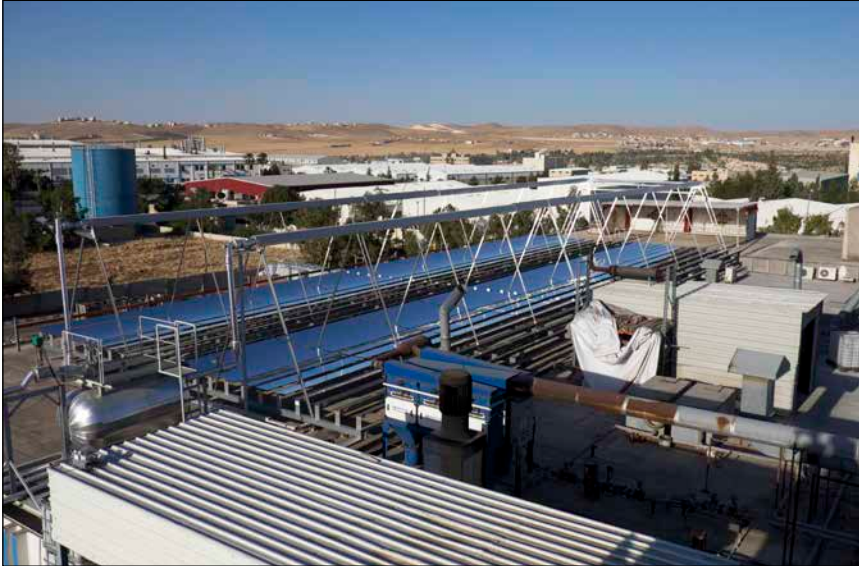
Bild 1: Mit den Fresnel-Kollektoren von Industrial Solar erzeugt RAM Pharma in Jordanien Direkt Dampf, der im Prozess zum Sterilisieren sowie zum Trocknen oder Befeuchten verwendet wird.
