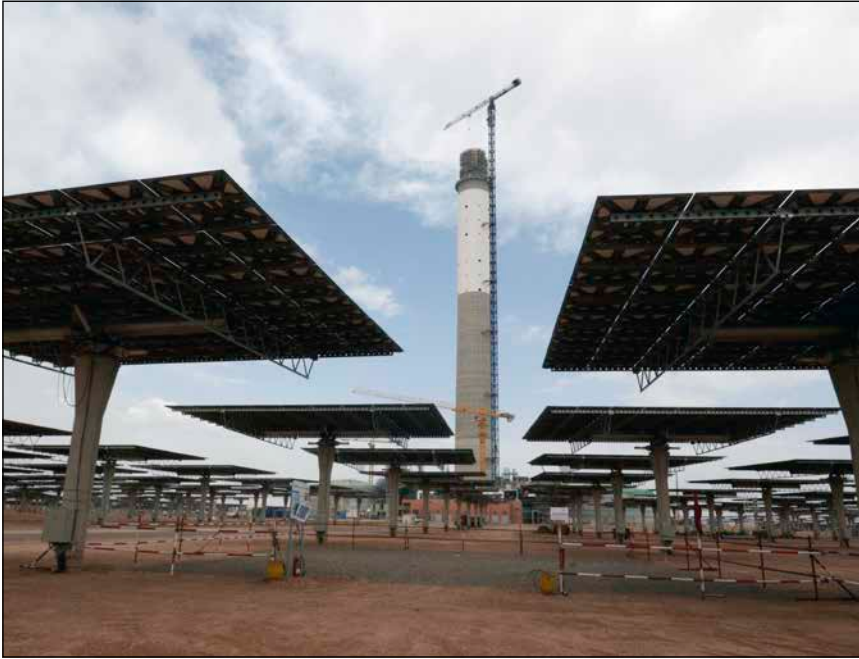
Bild 1: Baustelle des Solarturmkraftwerkes Noor III in Ouarzazate
