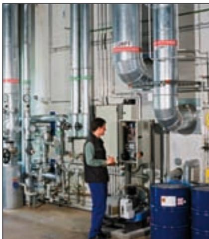
Bild 1: Biomasseheizkraftwerk Pfaffenhofen: Kontrolle des Steuerschranks der Vakuumpumpe
