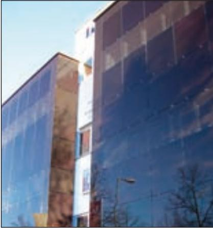
Saniertes Gebäude der Baufirma Jako in München mit PV-Fassade
