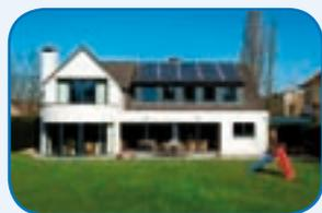
Suntech Power stellt ein neues leistungsfähiges 245 Watt Modul vor, das speziell für den Einsatz im Residential Segment sowie für kleine kommerzielle Dachinstallationen im europäischen Markt entwickelt wurde. Das monokristalline 60-Zellen Modul **STP245S-20/Wd** neutralisiert die anfängliche lichtinduzierte Degradation (LID), so erhalten Kunden eine höhere Wattleistung als die angegebene Mindestleistung und ein ausgezeichnetes Preis-/Leistungsverhältnis.
