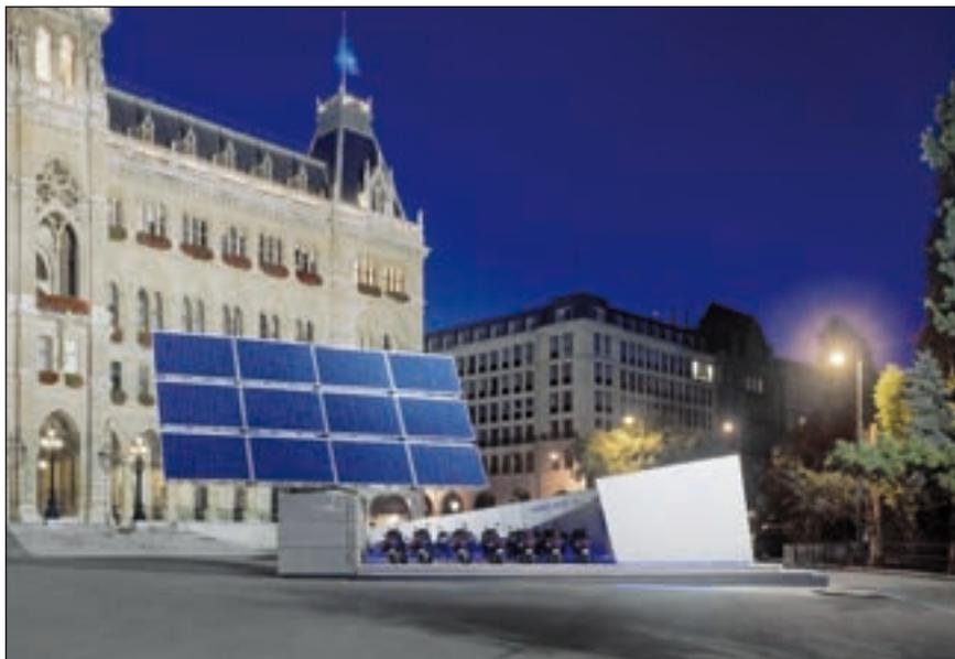
Bild 1: Netzautarke Ladestation von Solon mit RedOx-Flow-Pufferakku
