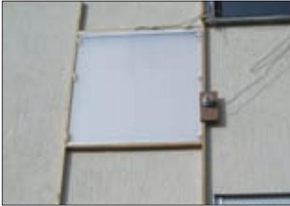
Bild 1: Mit Nanogel gefüllte Stegdoppelplatte an der Südfassade
