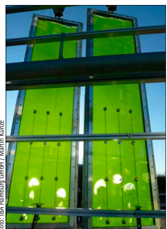
Bild 2: In der Fassade des BIQ sprudelt es schon. Die Luftblasen durchmischen die Algenbrühe, so dass die Algen immer nur kurz an der Oberfläche bleiben. Das Bild unten rechts zeigt den Versuchsreaktor.
