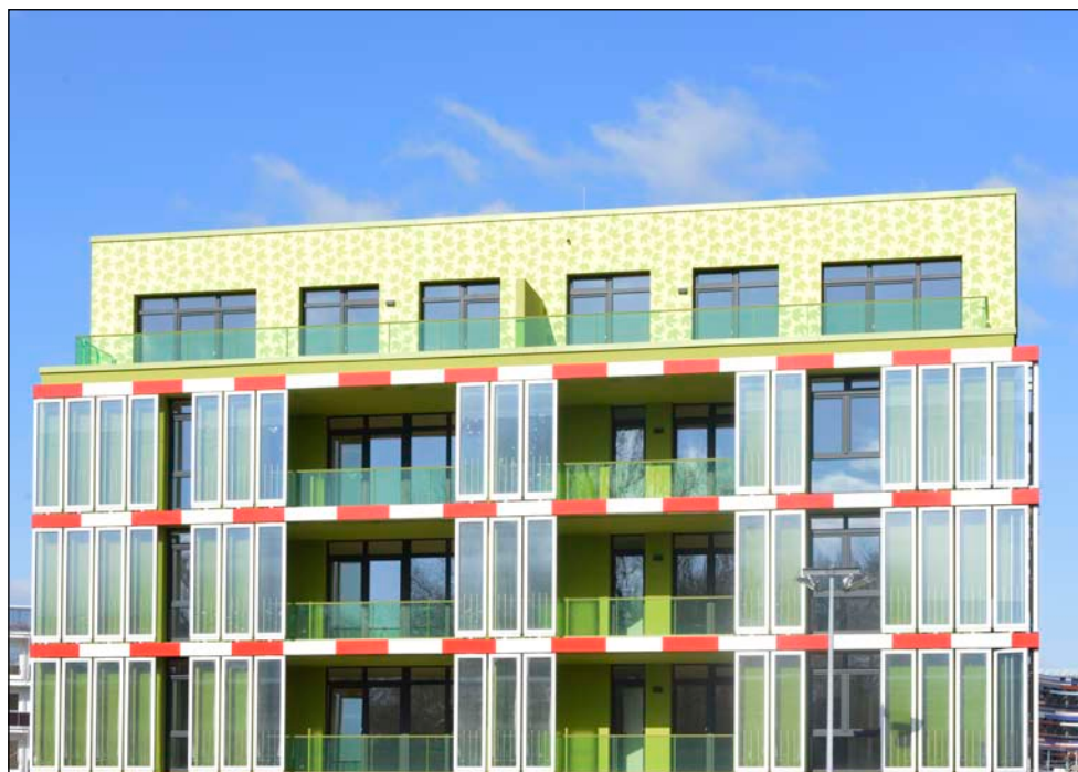
Bild 2: In der Fassade des BIQ sprudelt es schon. Die Luftblasen durchmischen die Algenbrühe, so dass die Algen immer nur kurz an der Oberfläche bleiben. Das Bild unten rechts zeigt den Versuchsreaktor.
