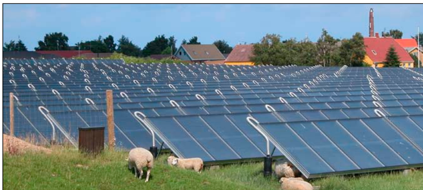
Bild 1: Solarthermie als Freiflächenanlage bei der Marstal Fjernvarme auf der dänischen Insel Aerö. Die Kollektorfläche wurde auf 33.400 m 2 , entsprechend einer Nennleistung von 23,4 MW th , erweitert. Die Kosten betrugen rund 175 Euro/m 2 .
