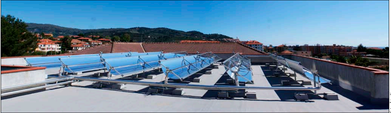
Bild 1: Trivelli Parabolrinnen, wie hier in einer kleinen Aufdach-Variante, sind der Klassiker unter den Mitteltemperatur-Kollektoren.
