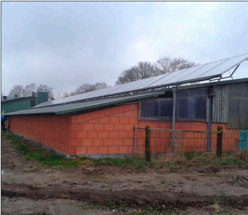
Bild 1: 86m<sup>2</sup> Flachkollektoren auf Ferkelstall
