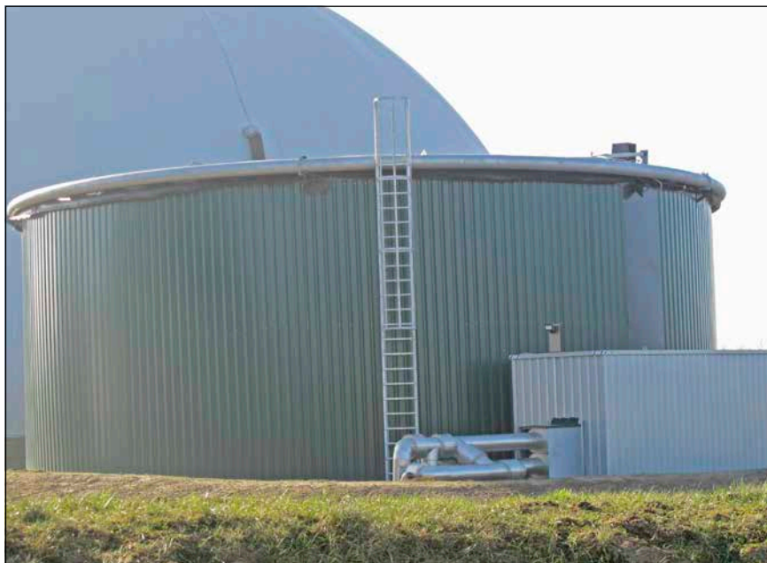
Bild 2: Wärmespeicher dienen dazu, dass Wärmeversorgung und Stromproduktion entkoppelt werden
