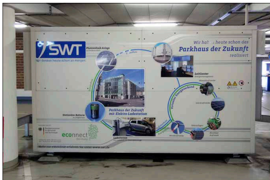
Bild 3: Die Redox-Flow-Batterie der Stadtwerke Trier SWT stand während des Forschungsprojekts direkt am Eingangsbereich des City-Parkhauses und versorgte mittels PV-Strom zwei Ladesäulen für Elektroautos
