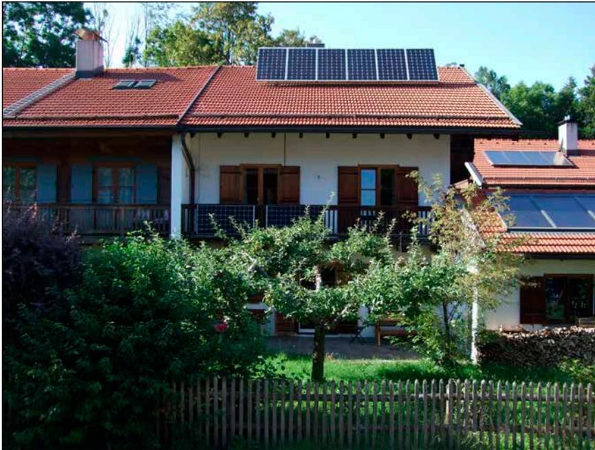
Bild 1: Im Jahr 2011 erneuerte PV-Anlage mit zwei zusätzlichen Modulen am südlichen Balkongeländer
