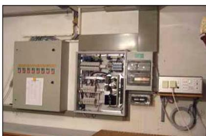
Bild 5: v.l. Heizungsregelung mit Palm-top-PC, PV-Schaltschrank mit Laderegler und Trapezwechselrichter
