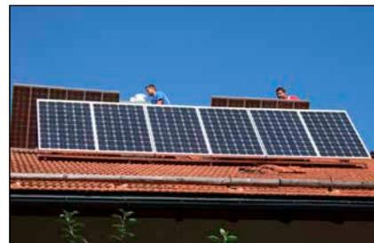
Bild 4: 2011 – Montage des neuen Solargenerators mit 1.500 Wp und Rückbau der Altanlage
