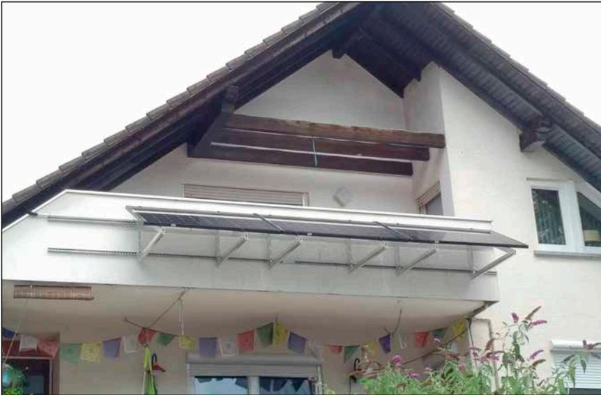
Bild 1: PV-Anlage als Balkonüberdachung
