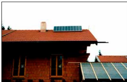
Bild 2: 1988 – ursprünglicher Solargenerator mit 500 Wp aus 10 Modulen vom Tollwood
