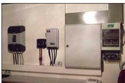
Bild 6: v.l. Sinuswechselrichter, 2 Laderegler und PV-Schaltschrank nach der Erneuerung
