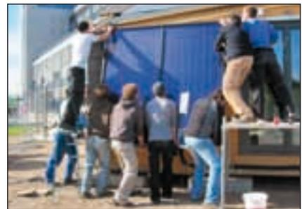
Bild 1: Studenten des Teams living EQUIA bei der Montage eines Thermiekollektors
