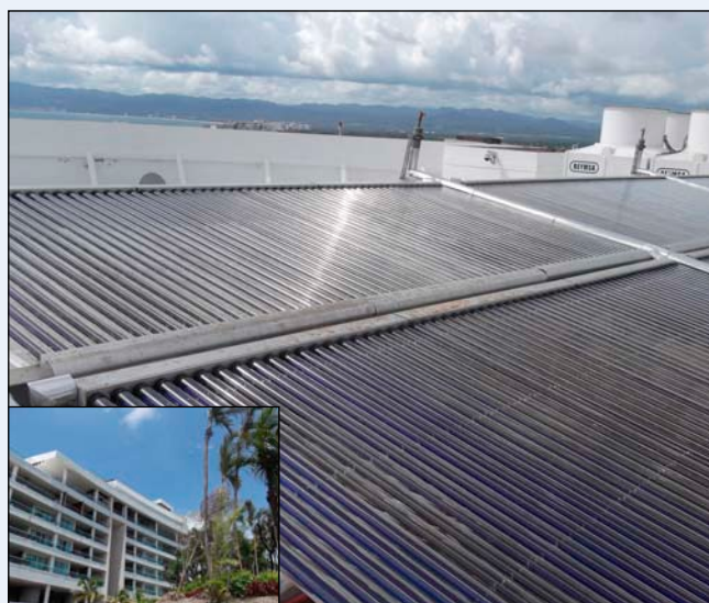
Bild 2: s-power-Anlage mit eigensicherer Heatpipe für ein Hotel in Mexiko
