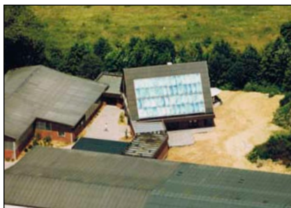
Bild 2: Bild vom Haus mit Kollektorfeld (Südansicht)
