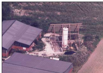
Bild 1: Bornefelds Speicher steht (Südansicht)
