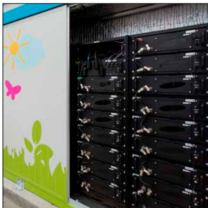
Bild 2: Batteriespeichercontainer an einer Schnellladestation für Elektrobusse bei den Stadtwerken Münster (schwarz im Vordergrund die Lithiumionen-Batterie mit Zellen der Firma Samsung SDI, nicht sichtbar direkt dahinter darin ein bidirektionaler Umrichter und die Systemsteuerung)
