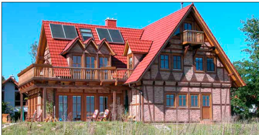
Bild 2: Flachkollektoren auf einem Einfamilienhaus
