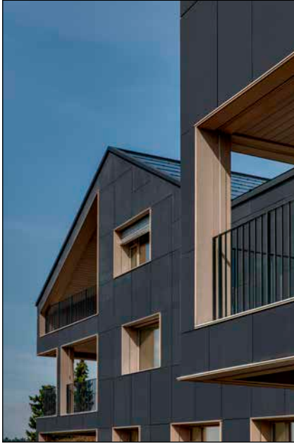
Bild 1: Brütten: Die matte Oberfläche der Dünnschichtzellen war Voraussetzung für die Installation einer PV-Fassade im Wohngebiet.
