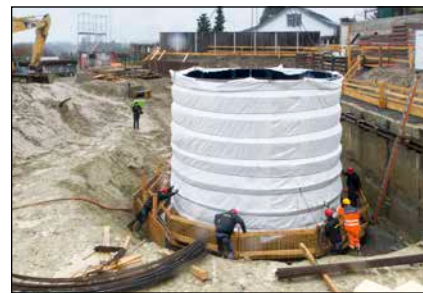
Bild 3: Brütten: Zwei konventionelle, wärmeisolierte Stahl-Email-Tanks dienen als thermische Speicher. Für eine gute Schichtung im Speicher wurden schlanke, hohe Behälter gewählt. Das warme Wasser (max. 70°C.) wird im Winter direkt für die Boden-/Wandheizung genutzt.
