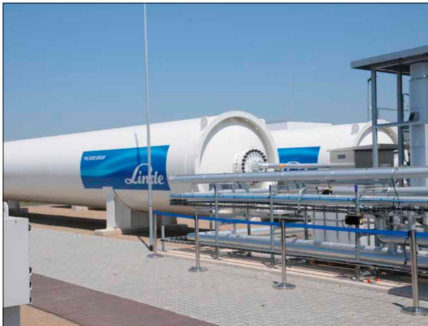
Bild 2: Zur Zwischenlagerung des in Mainz erzeugten Wasserstoffs stehen zwei Speicherbehälter mit je 82 m³ bereit.
