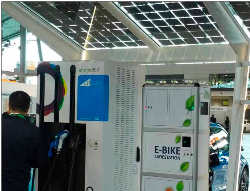
Bild 1: Auch Ladesäulen (links für Elektroauto, rechts für E-Bike) können mit PV und Batteriespeichern kombiniert werden.
