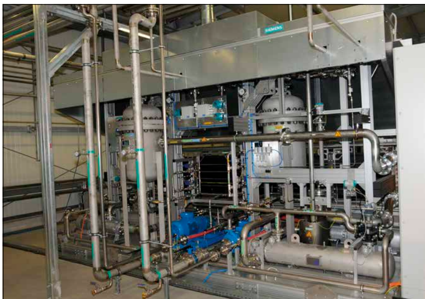
Bild 3: Der Energiepark Mainz enthält drei PEM-Elektrolyseure von Siemens, Typ Silyzer 200, die selbst mit extrem schnellen Lastwechseln umgehen und Wasserstoff bis zu 35 bar erzeugen können.
