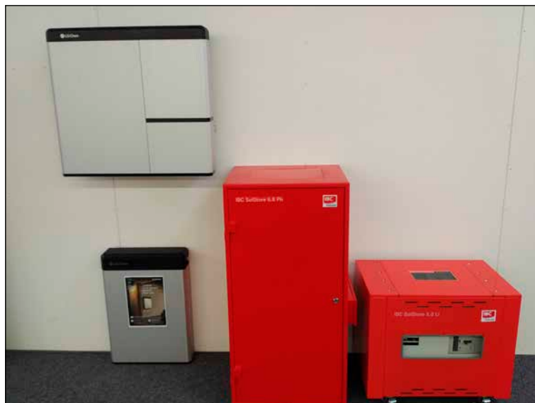
Bild 2: Ein Bleispeicher (rot, Mitte) umgeben von verschiedenen Lithium-Ionen-Akkus
