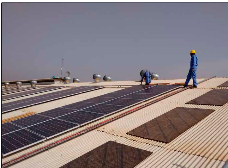
Bild 3: Installateure der Solaranlage bei der Arbeit
