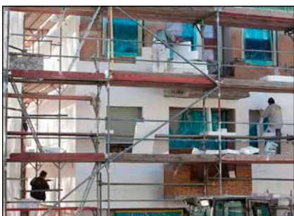
Bild 2: Fassadendämmung in Berlin-Hakenfelde, Kornburger Weg
