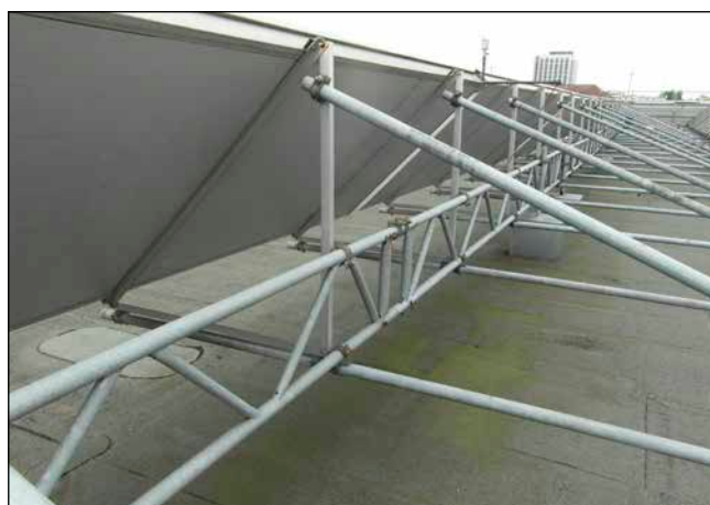
Bild 3: Die Leichtgewicht-Tragkonstruktion aus Gerüstbauteilen zeigt sich unverwundlich und korrosionsresistent.
