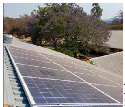
Bild 2: Teilgenerator auf dem Ostdach: Zwei Drittel der PV-Module sind nach Osten ausgerichtet, ein Drittel nach Westen.
