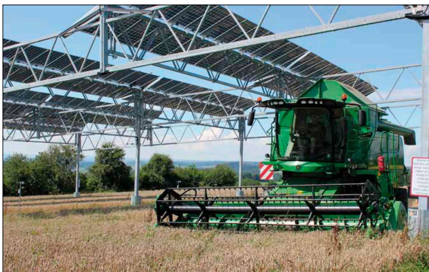
Bild 2: Die PV-Module sind so hoch montiert, dass selbst Mähdrescher unter durch fahren können.
