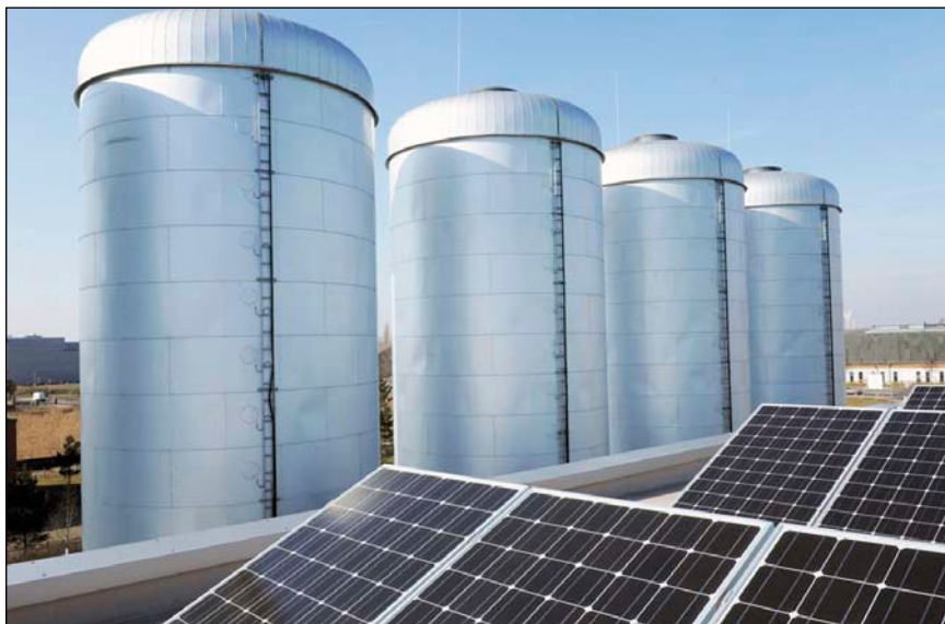
Bild 2: PV-Anlage (21 kWp) auf dem Dach eines Blockheizkraftwerkes in Berlin-Adlershof mit 2.700 PS Leistung (4 gasgeführte Motor-BHKW, 2 MW el und 2 MW th ), die vier Wärmespeicher haben ein Volumen von 2.000 m 3 .
