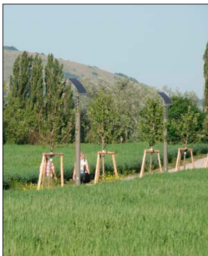
Bild 2: Wegebeleuchtung mit Ecostar Double Sol, Stahlmast und gebogenes laminiertes Solarmodul (links) Nachtsicht der Leuchte mit Lerchenholzmast (mitte) und transparentem Glasmodul (rechts)
