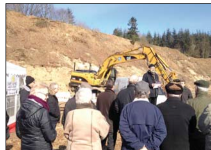
Bild 2: Baubeginn für den Speicher in Dronninglund
