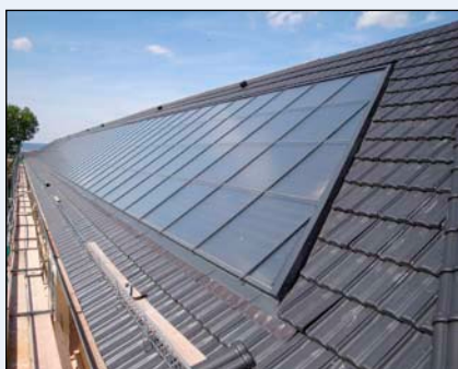
Bild 2: Thermische Solardachflächen in Indachkollektorbauweise auf drei Wohnblockeinheiten
