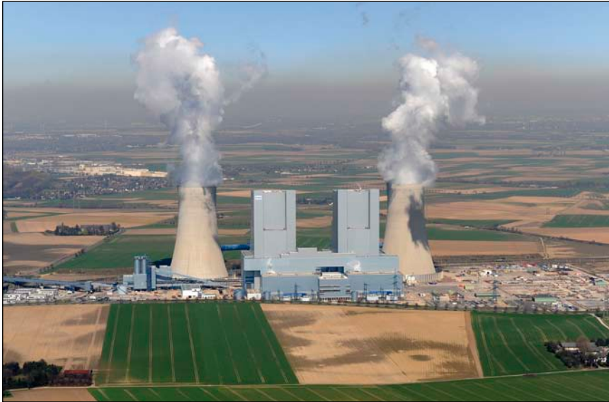
Bild 3: Zwei neue RWE-Braunkohleblöcke sind seit August 2012 in Grevenbroich-Neurath mit sogenannter BoA-Technologie in Betrieb: Leistung jeweils 1.100 MW.
