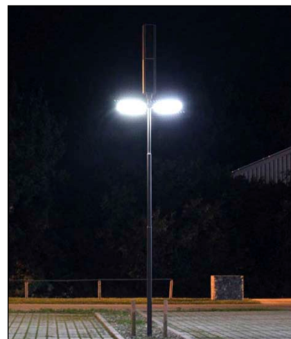
Bild 5: Elobau GmbH & Co. KG Firmenparkplatzbeleuchtung, Nachtaufnahme
