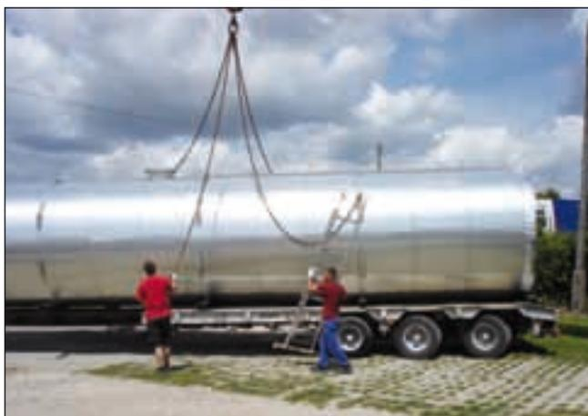
Bild 2: Anlieferung und Montage des Gärbehälters
