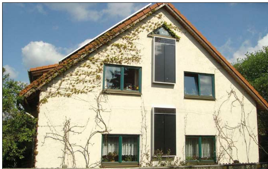
Bild 1: Wohnhaus bei Leipzig – dezentrale Plusenergielüftung mit zwei Twinsolar 1.3 Compact
