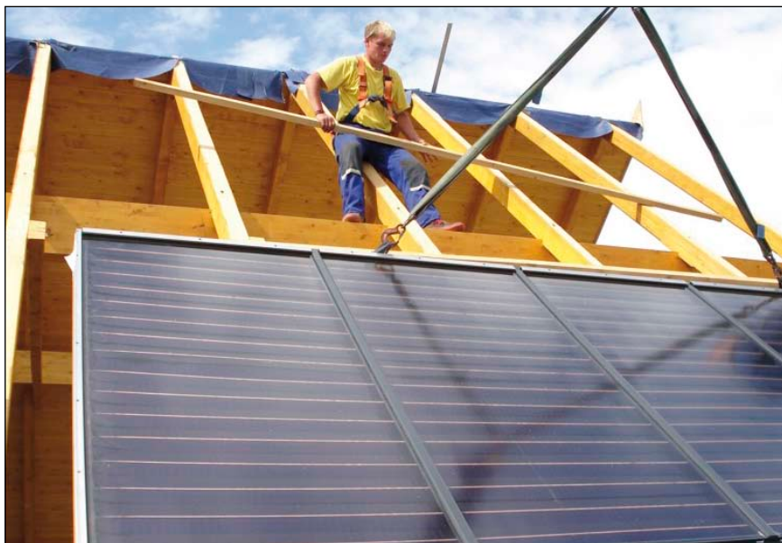
Bild 1: Montage eines großen Flachkollektors
