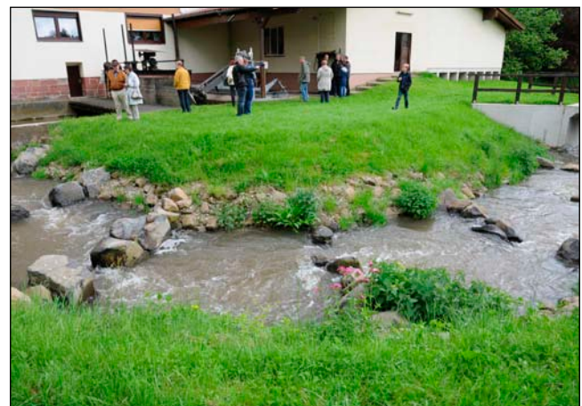
Bild 11: Fischpassagen ermöglichen, Wasserkraftanlagen in beide Richtungen zu passieren. Hier eine neue Anlage an der Schwalm-mühle im nordhessischen Neuental-Schlierbach.
