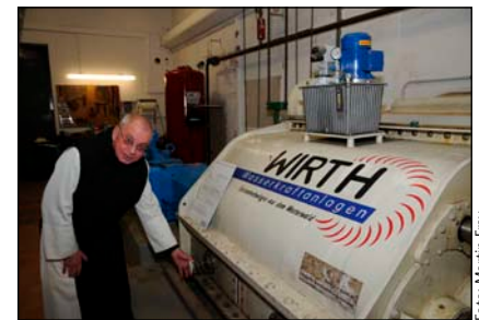
Bild 3: Bei Durchströmturbinen gelangt das Wasser auf eine sich drehende Walze, die besonders für niedrige Fallhöhen geeignet ist. Hier abgebildet ist eine Banki-Durch- ström-Turbine der Wirth Wasserkraftanla- gen GmbH mit 95 kW in der Abtei Mari- enstatt bei Hachenburg.
