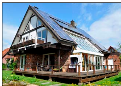
EFH in Dülmen als „Kraftwerk“
