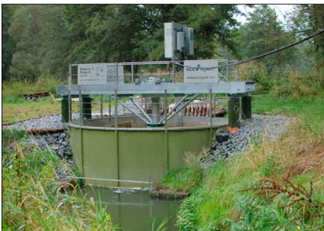
Bild 10: Das „Fischfreundliche Wehr“ – hier das Pilotprojekt bei Dresden – besitzt ein vertikal gelagertes langsam drehendes Wasserrad. Das Produkt der ecoligent und Käppler & Pausch GmbH ist in Leistungen zwischen 3 und 5 kW erhältlich.
