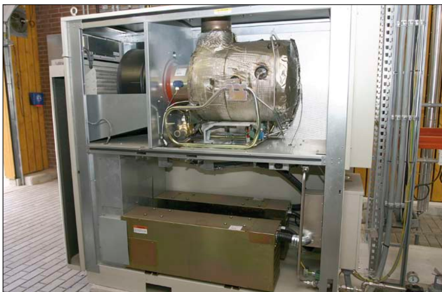
Bild 3: Geöffnete Mikrogasturbine
