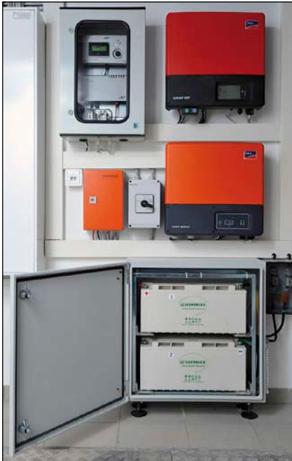
Bild 1: AC-Speichersystem mit Bleiakkus und Backup-Funktion
