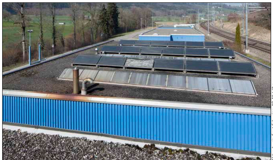
Vorher: Ein Glasbruch setzte die alte Sonnenkollektor-Anlage außer Betrieb und gab den Impuls zu einer Sanierung
