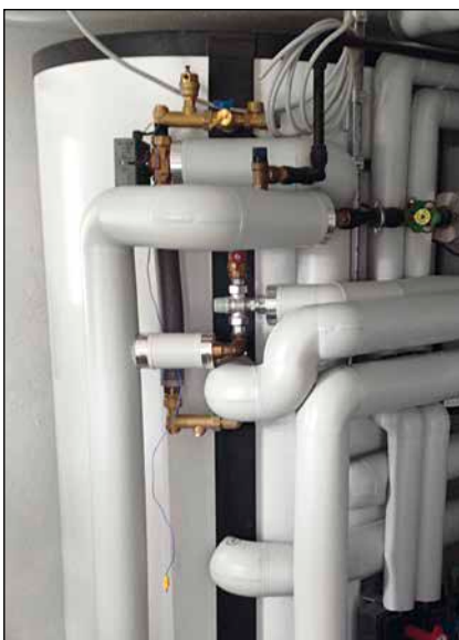
Bild 2: Ein Fall fürs Lehrbuch: perfekt gedämmte Rohrleitungen bis zum Speicher
