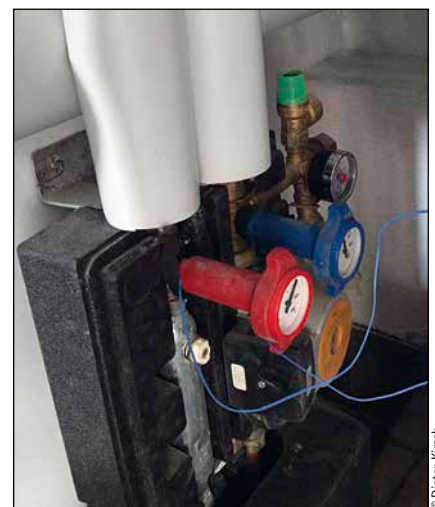
Bild 3: Die Verkleidung wird abgenommen und die Messfühler für die Temperaturmessungen an Vor- und Rücklauf angebracht. Dabei ist Vorsicht angeraten: Das Sicherheitsventil ist hier nicht mit einer Ablaufleitung verbunden, so dass heißer Dampf ungehindert in den Raum austreten kann
