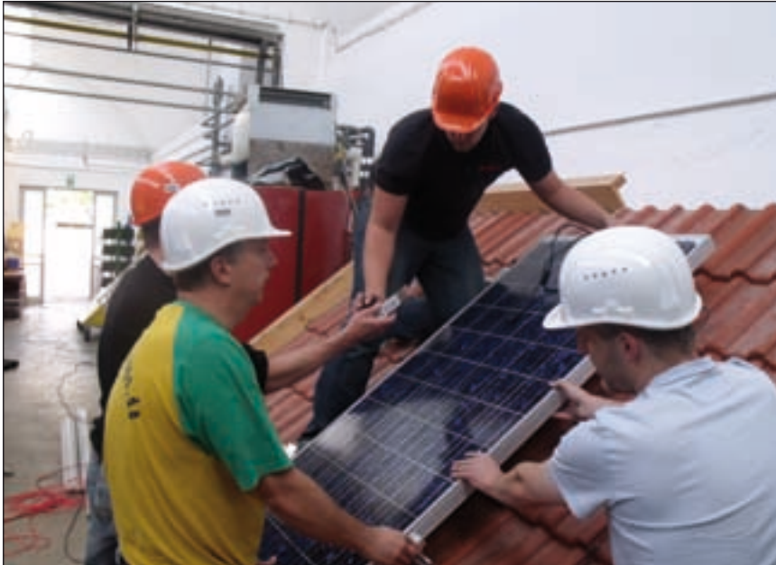
Bild 1: DGS-Solarschule Nürnberg: Unter Anleitung von Solarexperte Oskar Wolf wird ein Solarmodul montiert.
