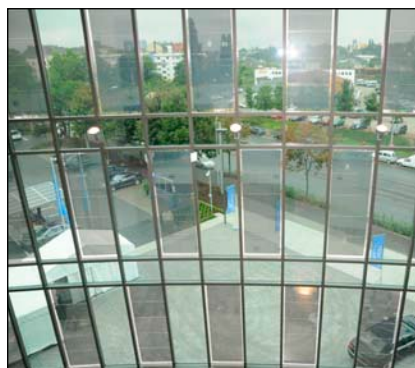
Bild 7: Die Südfassade der SCHOTT Solar Headquarters in Mainz enthält im Wechsel Standardverglasung und ASI THRU-Module. Dies sind semitransparente Dünnschichtmodule in Wärmeschutzverbundtechnik.
