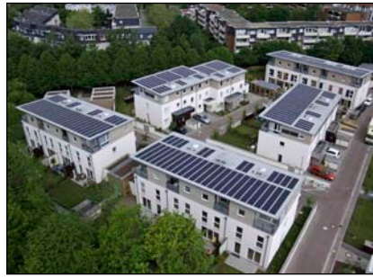
Bild 4: Die Dächer des „Eco-Carree Brucknerweg“ in Laatzen bei Hannover erzeugen mit Dachbahnen aus Dünnschicht-Solarzellen von Alwitra elektrische Energie.
