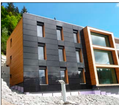
Bild 6: Für das „Ecobauhaus“ im schweizerischen Laax hat der österreichische BIPV-Lieferant MGT-esy eine komplett geschlossene Fassade aus opaken PV-Elementen geschaffen.
