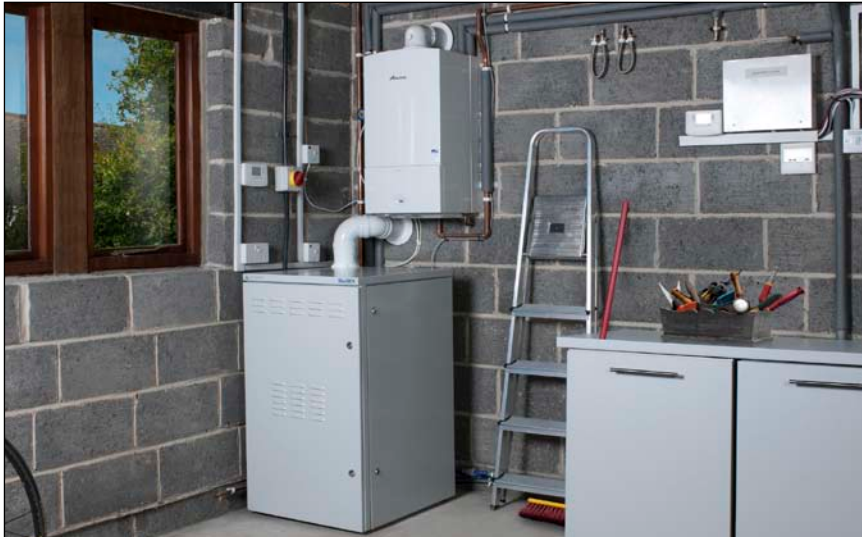
Bild 1: BlueGen von Ceramic Fuel Cells (CFC), Mikro-Blockheizkraftwerk mit Brennstoffzelle, produziert in Deutschland
